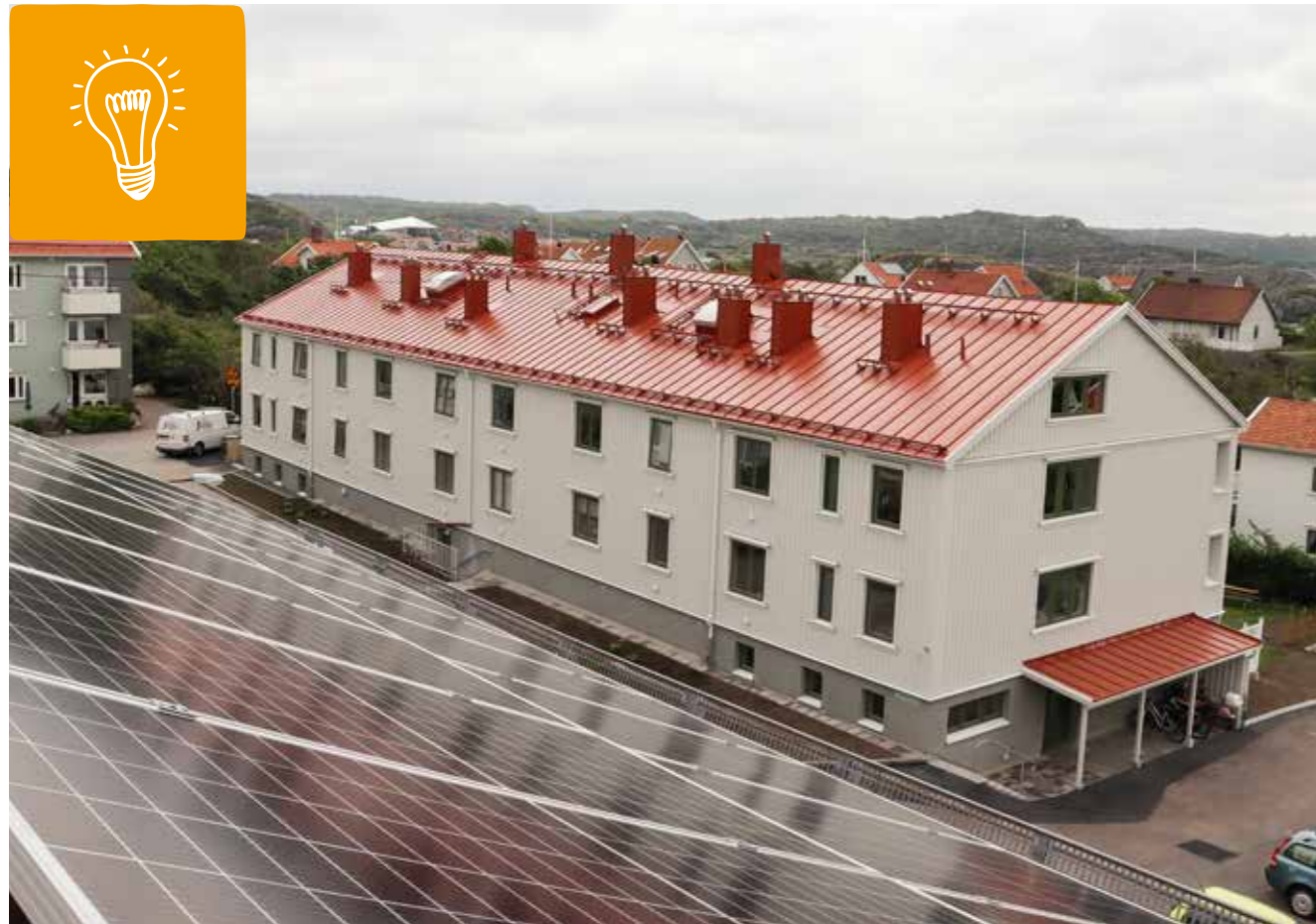
Den stora satsningen på solceller gör att vi i dagsläget kan spara över 70 ton koldioxidutsläpp årligen. Bild från Bohusgatan, Koön.
