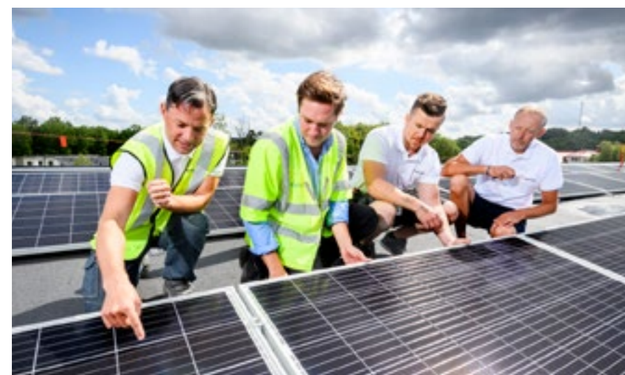
Från vänster: Mikael Olsson (Västbygg), Martin Everbring (Förbo), Joshua Ormsby (Fyrstads el) och Vytautas Dubauskas (Vegasolar). "Det är viktigt med ett fungerande samarbete mellan oss och bygg-entreprenören", säger Martin. "På Tallspinnaren har samarbetet fungerat väldigt bra och vi har samtidigt haft kul tillsammans på vägen".
