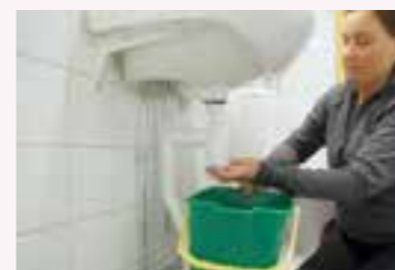
3. Skruva loss de delar under vattenlåset som håller fast rören – det kommer att rinna ut lite vatten.
