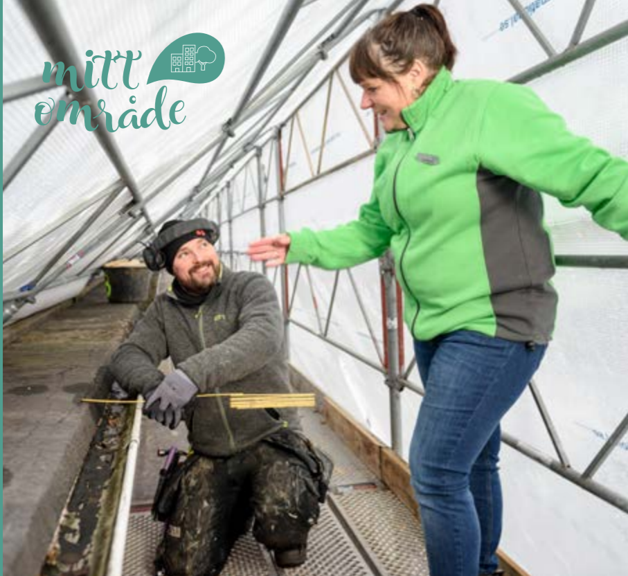
Byggnadsarbetaren Torbjörn och Lena diskuterar det pågående bygget i Stommen, Landvetter.
